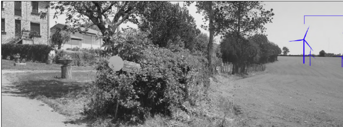
VARIANTE 2 - POINT DE VUE À L'AIRES D'ÉTUDE RAPPROCHÉE : 28. DEPUIS LE LIEU-DIT « SAINT-MAURICE » SUR LA COMMUNE DE DURENQUE
